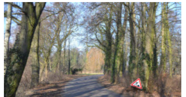
In zwei Abschnitten wird die Mühlenstraße saniert.
